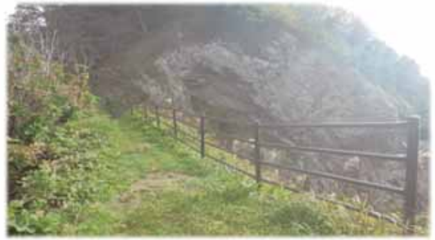
※願掛公園遊歩道手摺改修工事
