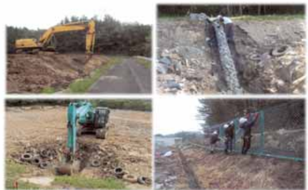
※不燃物埋立最終処分場整地工事
