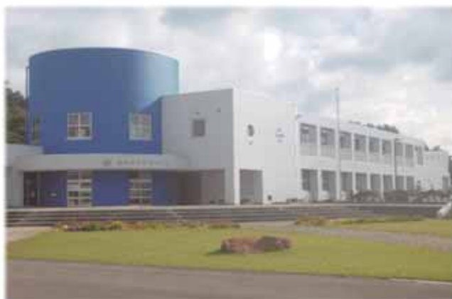
※改修後の佐井中学校
