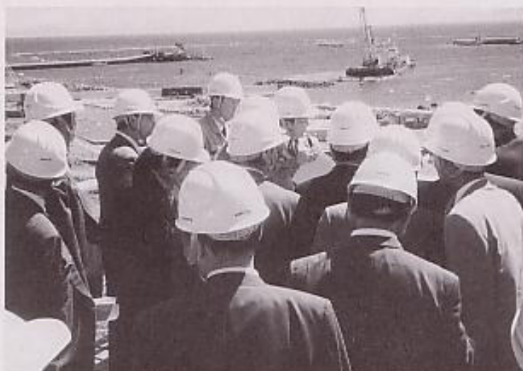
展望台にて港湾工事の概要の説明を受ける
