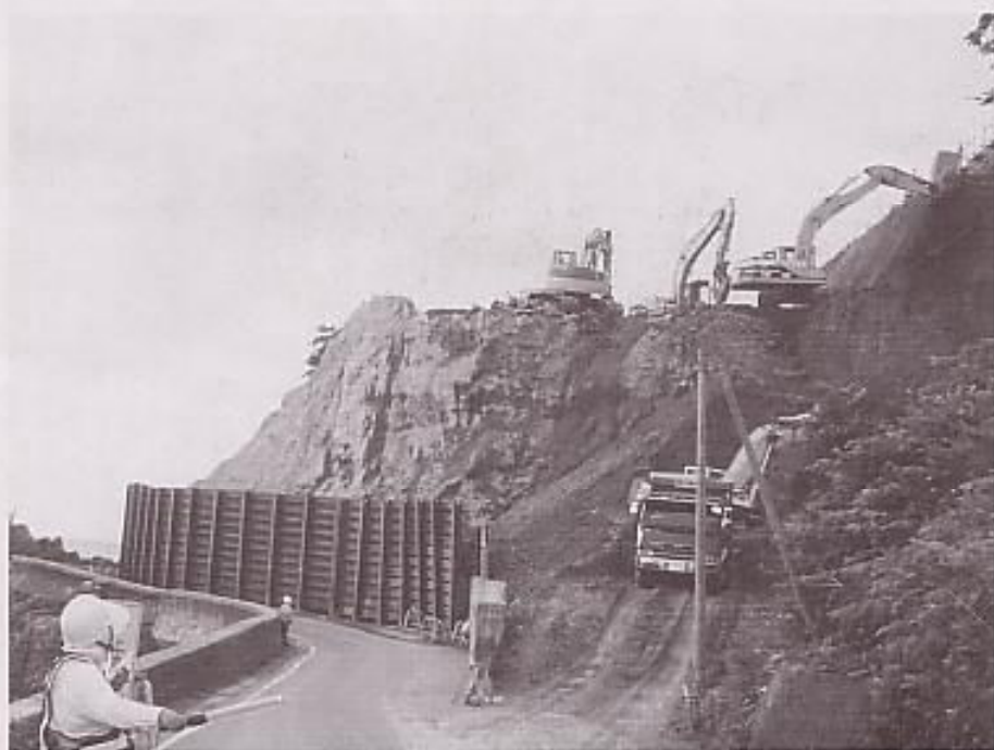
国道338号特殊改良工事：礪谷地内
