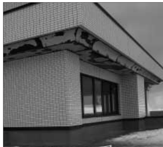
今年度はアルサス展望室軒天の改修工事等が行なわれている
