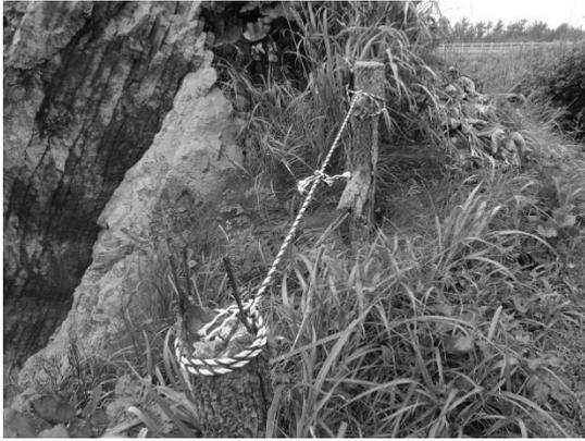
破損し鉄筋がむき出しになっている支柱
