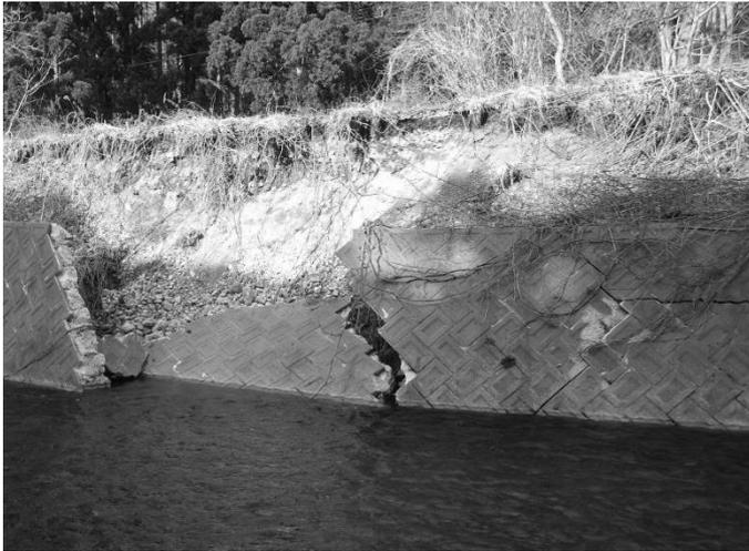
コンクリート部分が倒壊した古佐井川上流の護岸
