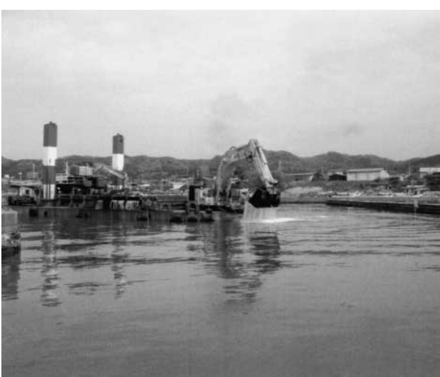
原田漁港の土砂撤去の様子（工事は5月に完了）
