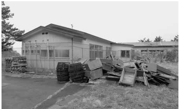
学校の周りにある私物を撤去してからの着工となる
