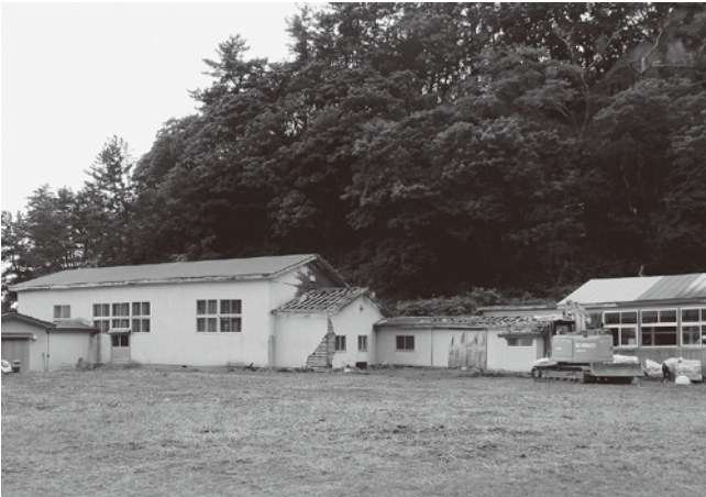
解体工事が始まった旧磯谷小中学校
