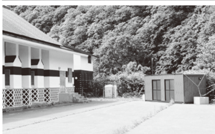
プレハブは10棟購入し村内各地区に設置 (写真上は川目地区、写真下は福浦地区)
