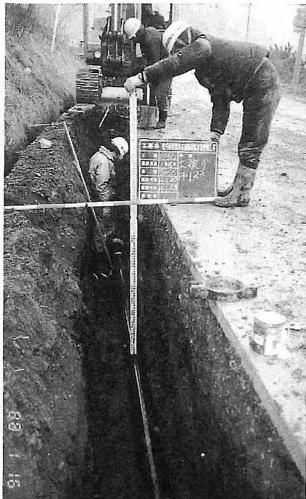
着々と配水管の整備が進む佐井地区簡易水道の工事
