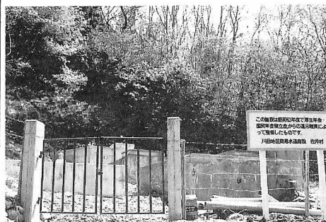
▲川目地区簡易水道施設
