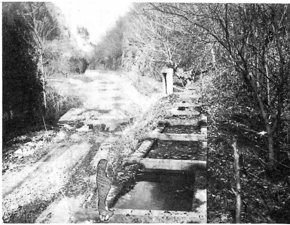
補 修 さ れ る 水 路
